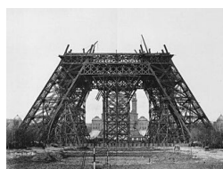
20 mars 1888 : montage des poutres horizontales sur l'échafaudage du milieu.
