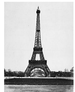
Fin mars 1889 : vue générale de l'ouvrage achevé.
