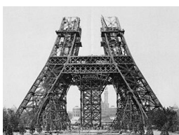
15 mai 1888 : montage des piliers au-dessus du premier étage.
