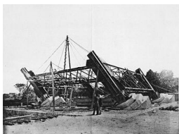
18 juillet 1887 : commencement du montage métallique de la pile no 4.
